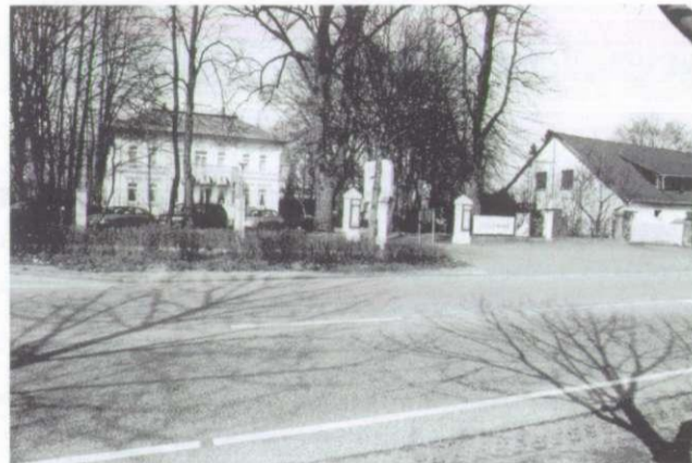
Abb. 4: Lage der Zollstation Höltigbaum an der (Alten) Sieker Landstraße (B 435), Foto 2001
