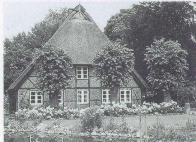
Abb. 25: Rückseite der Kate nach der Rekonstruktion, 2003
