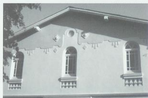
Abbildung 6: Detail des Wirtschaftsgebäudes des Bauernhofs Hinsch, 2005
