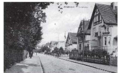
Abbildung 7: Brockdorffstraße 1916 ehemaliger Feldweg 1781, damalige Feldstraße, vor 1912 benannt, 1950 umbenannt, mit hohen giebelständigen Villen, teilweise mit Fachwerkgiebeln.
