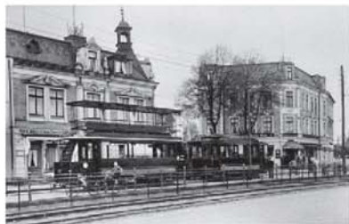
Abbildung 8: Doberaner Weg 1934 1900 Parallelstraße am Bahnhof Rahlstedt mit Kleinbahn nach Volkesdorf. 1904 bis 1923 Personenverkehr, bis 1934 nur Güterverkehr, danach Einstellung. Umbenennung 1950.
