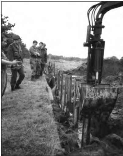
Abbildung 7: Rückbau des Handgranatenwurfstandes
