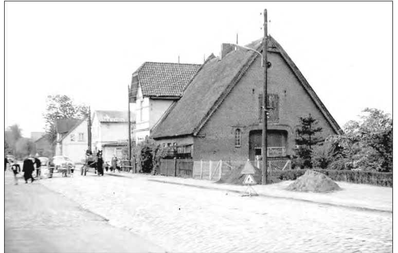
Abbildung 3: Krögers Kate mit später angebautem Wohnhaus, dahinter Hotel Meiendorfer Park und Haus Nr. 99, Foto 1958
