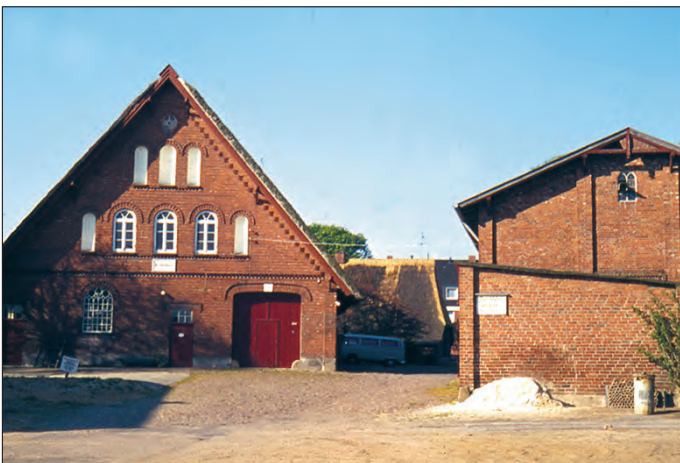
Abbildung 5: Hof von Walter Schierhorn, seit 1988 unter Denkmalschutz, 2009 mit modernen Wohnungen ausgestattet, Foto 1976
