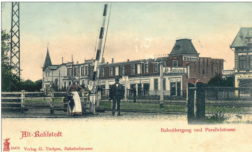
Abbildung 12: Bahnübergang und Parallelstraße, heute Doberaner Weg, um 1900
