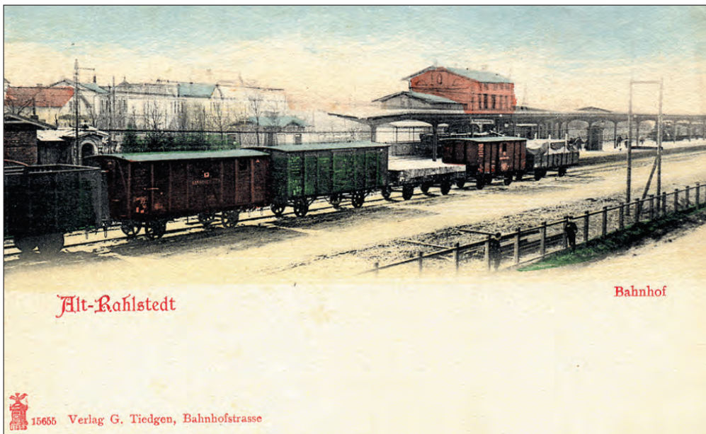
Abbildung 11: Bahnhofsanlage um 1900; außer den Gleisen für Personenverkehr gab es ein weiteres für die Waggons.
