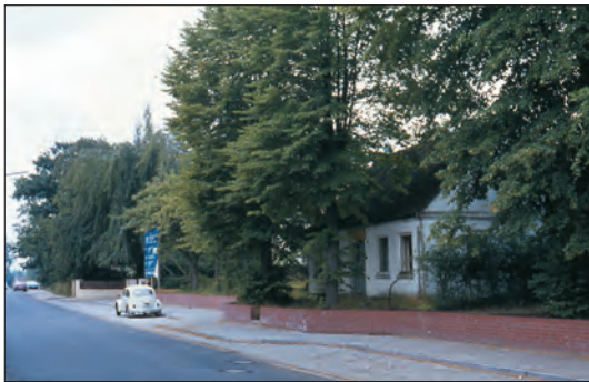
Abbildung 20: Pusbacks Wohnhaus 1976 kurz vor dem Abriss; die gerade neu gebaute Mauer steht noch.
