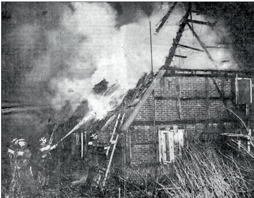
Abbildung 11: Kurz vor dem geplanten Abriss brannte dieses Bauernhaus von Willi Schilling in Neu-Rahlstedt, Heckende 5.
