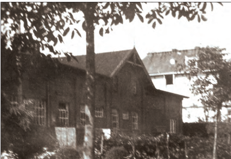
Abbildung 14: Hof Körtinge und Villa Stapelfelder Straße 30
