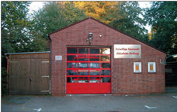
Abbildung 34: Unser Feuerwehrhaus in der Bekassinenau
