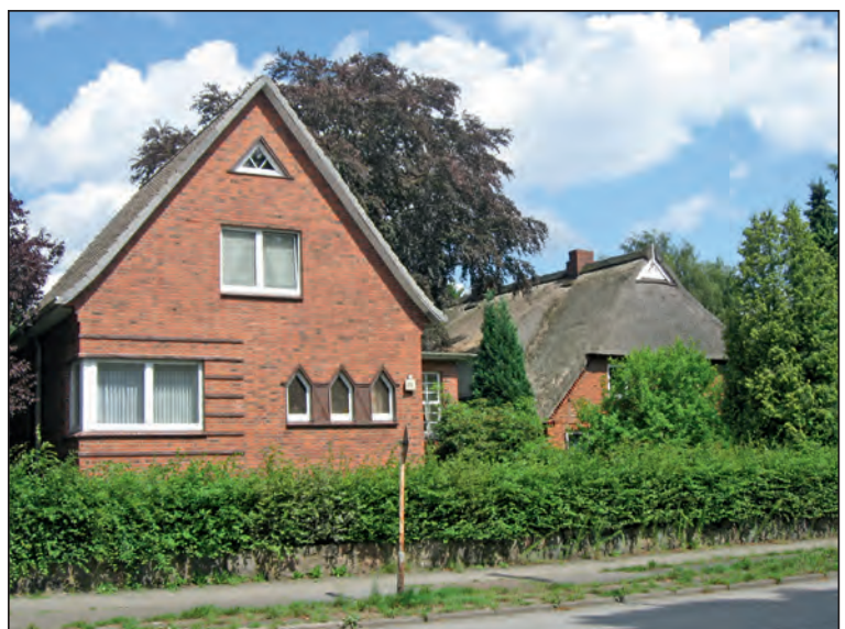
Abbildung 4: Ensemble von ehemals Heinrich Schierhorn in der Saseler Straße, vor Brandlegung und Abriss
