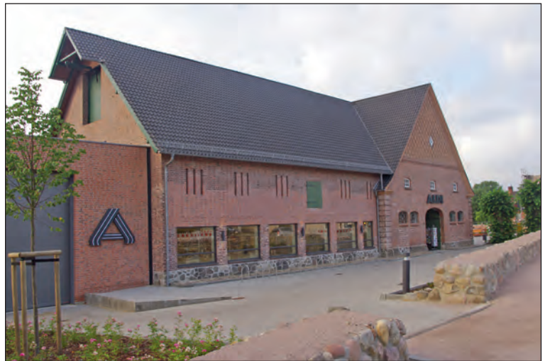
Abbildung 8: Der Krögerhof nach der Renovierung, Foto 2013
