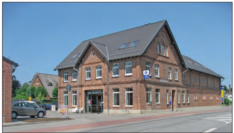
Abbildung 2: Der Hof von Randel, vormals Eggers, nach der Sanierung
