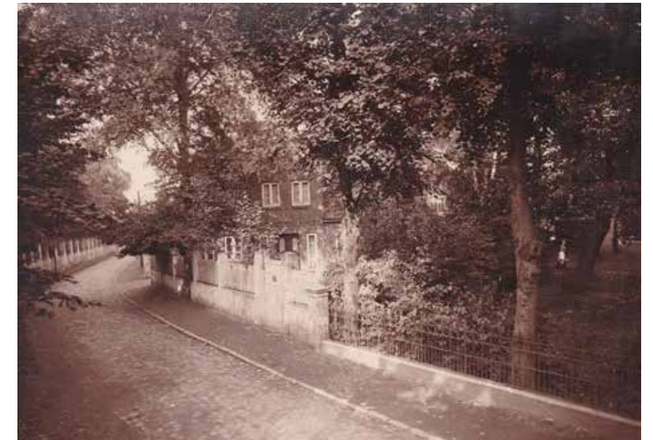
Wohnhaus Karl Wäger, Mühlenstraße Nr. 2, ca. 1920
