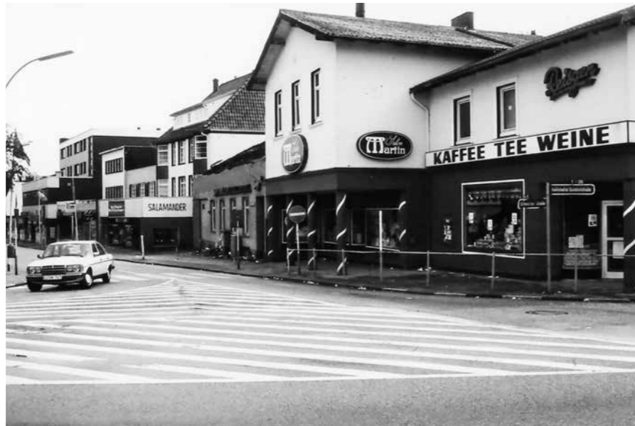
Foto 13 zeigt einen Blick von Kaffee Reisingen in die Schweriner Straße im Jahr 1979. Hinter dem Friseur wird gerade die Kaffeerösterei von Reisingen, abgerissen. Zur Zeit des Bahnhof-Hotel war das der Tanzsaal. Auch das Haus von Reisingen weicht später einem Neubau der Deutschen Bank. Schuh-Hittcher und dessen direkten Nachbarn mit der Nr. 2b und 2c bleiben erhalten. Dahinter sieht man den Neubau mit, Nr. 4, Schuh Kay.
