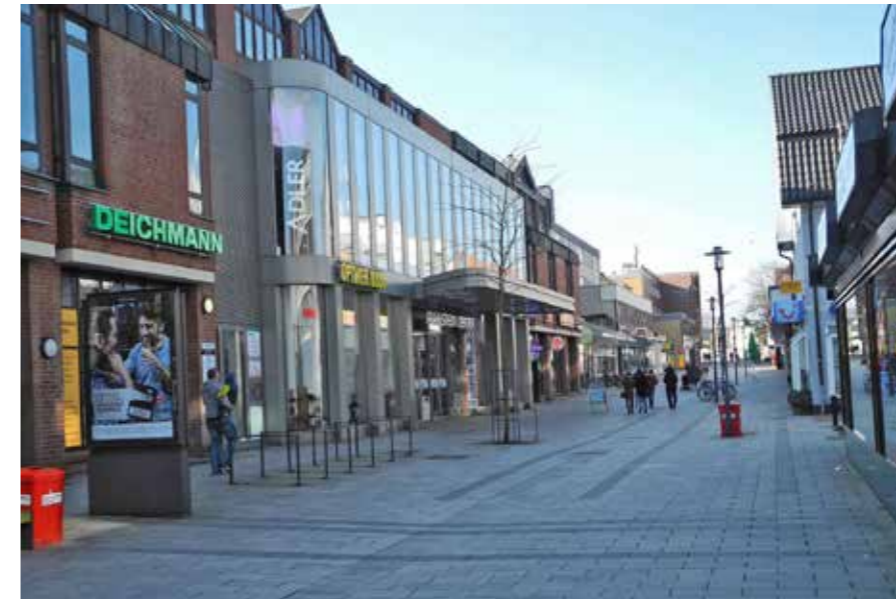
Das ist sie, die neue Fußgängerzone, nach einem Update im Jahre 2010. Mit der Rahlstedter Bahnhofstraße, dem Bahnhof, beiden Bus-Bahnhöfen, der Bahnunterführung bildet sie den neuen Ortskern. Dazu kommt noch eine neue Verkehrsführung mit Brücken, Ortskern-Umgehungsstraßen und Schrankenschließungen. Auch das Postamt erhält einen neuen Standort.
