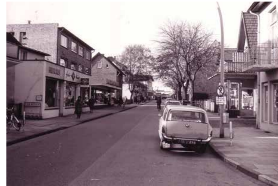
Ebenfalls aus 1967 ist dieses Foto in Richtung Bahnhof. Es zeigt noch die Straße, bevor im Jahr 1970 eine große Ortskernsanierung beschlossen wurde. Viele Häuser werden in den kommenden Jahren abgerissen werden, ein großer Umbruch, besonders in der Schweriner Straße steht an. Ein Sattler und ein Photogeschäft in Nr. 8, das Kaufhaus Weikert, Nr. 6, sind links zu sehen, rechts vorn eine Schnellreinigung. Beachten Sie das dritte Haus links, Nr. 4, das Haus mit dem Satteldach. Erste umfangreiche Veränderungen will ich zeigen.
