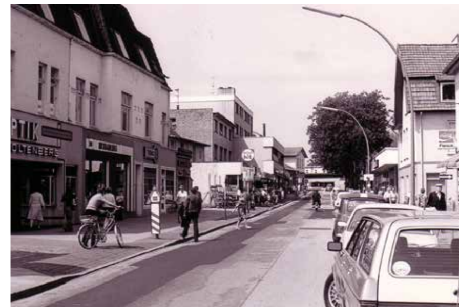
Dieses Foto 12 ist 1976 aufgenommen und zeigt die angekündigten Veränderungen. Hinter dem ersten Haus links bauen 3 Häuser nacheinander auf. Schuh hit bietet nun im zweiten Haus Schuhe an. Dahinter bleibt Kaufhaus Weikert – noch. Das vierte, höchste Haus, Nr. 4, ist neu und ersetzt das Haus mit dem Satteldach. Dort ist mit Schuh Kay ein Schuhhändler eingezogen. Allein dieses Haus existiert, es beherbergt aktuell eine Drogerie-Kette. Vorne links in Nr. 12, verkauften noch der Optiker Stoltenberg und Buchhändler und Galerist Peter Blänsdorf. Auf der rechten Straßenseite ist ein weiterer Neubau entstanden. In Nr. 9 ist der Pro-Markt eingezogen.
