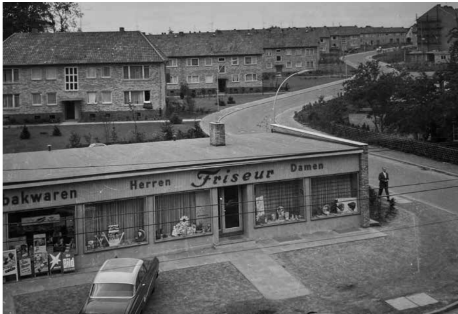
Bauvorhaben Timmendorfer Straße 1-15, Baujahr 1959.
