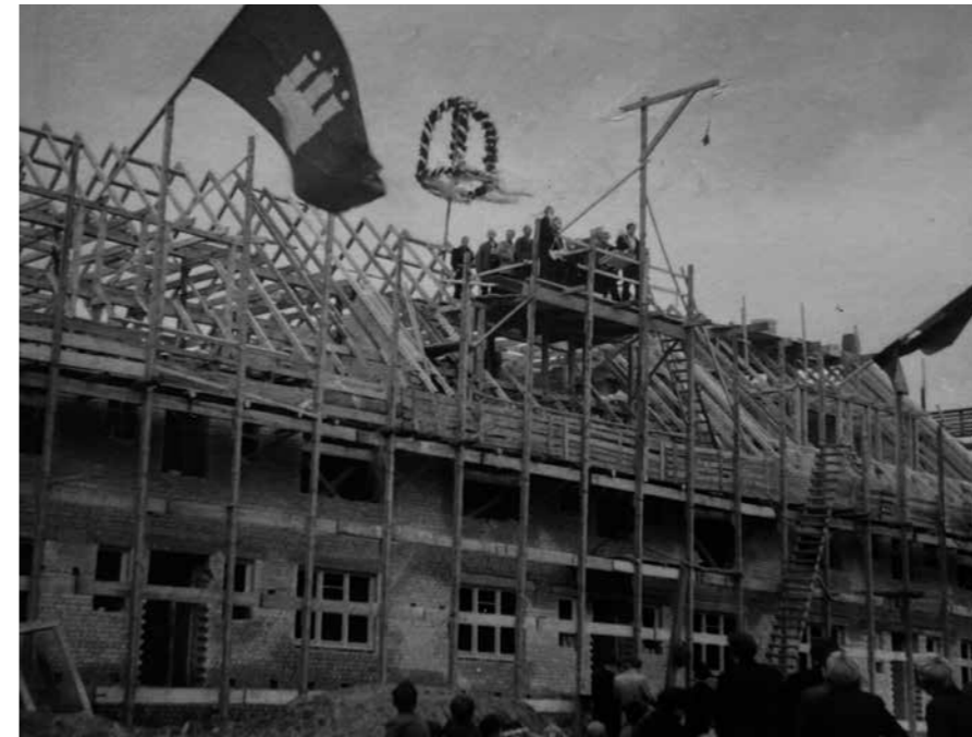
Bauvorhaben Redderblock 46-58, Richtfest 1950.
