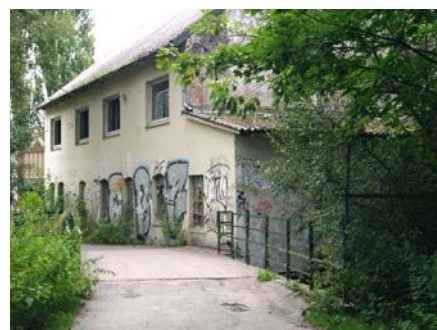
13: Altrahlstedter Kamp 1, die Ruine der Lackfabrik
