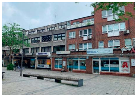
Abbildung 19: 3-4-stöckige Zeilenbauten Schweriner Straße
