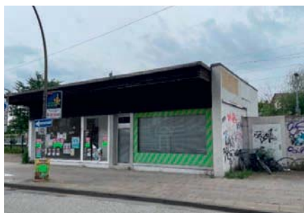
Abbildung 37: Leerstehendes Gebäude bei der Unterführung
