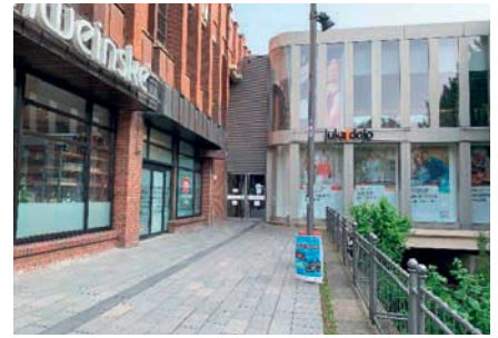
Abbildung 32: Center Eingang Schweriner Straße
