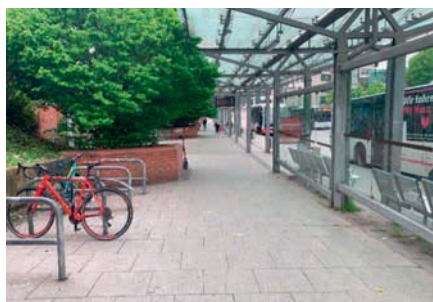
Abbildung 22: Busbahnhof Doberaner Weg
