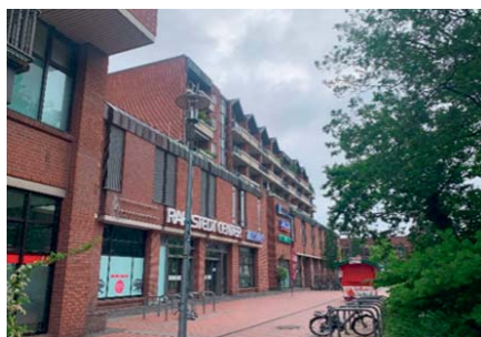
Abbildung 18: Rahlstedt Center mit aufgesetzten Wohnbauten
